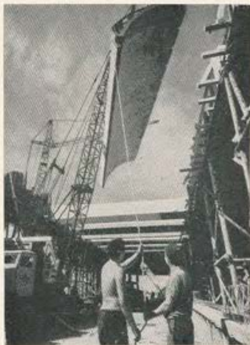
Elementos prefabricados montados a pié de obra
