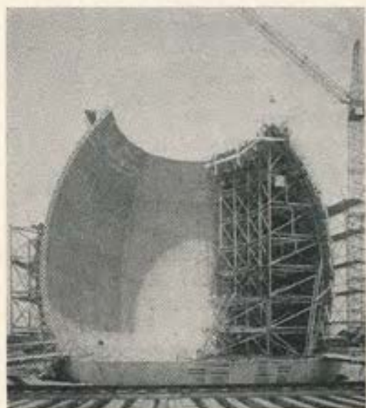
Encofrado de un depósito de cieno de pudrición
