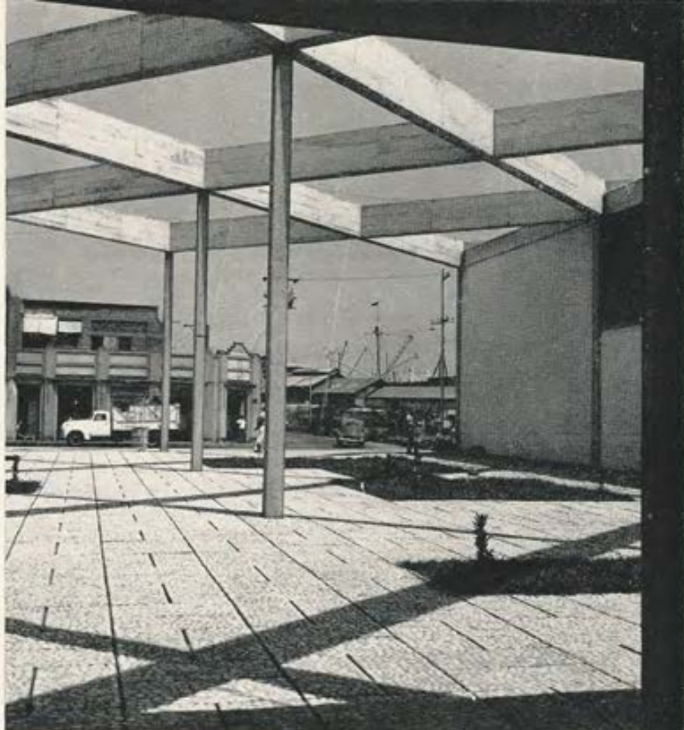
Detalle de la Aduana de Puerto Cabello - Arq. Julián Ferris
