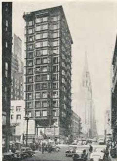
Edificio Reliance, Chicago, 1890 D. H. Burnham y J. W. Root
