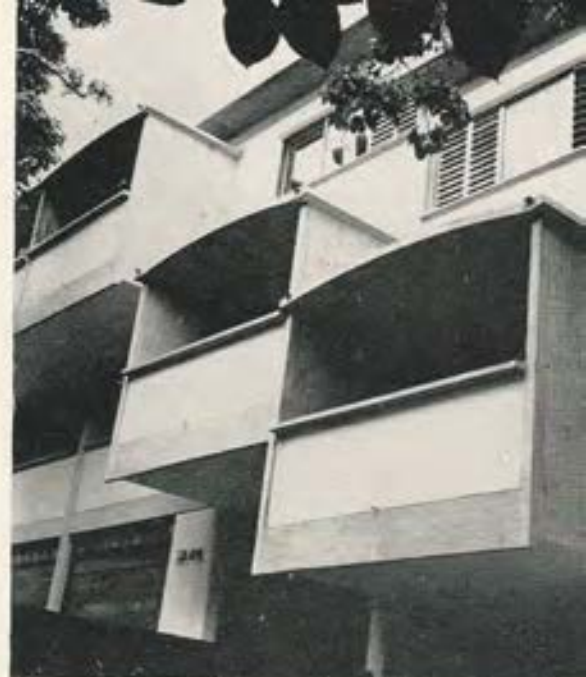
Edificio en Sebucán, Caracas-Arq. Julián Ferris
