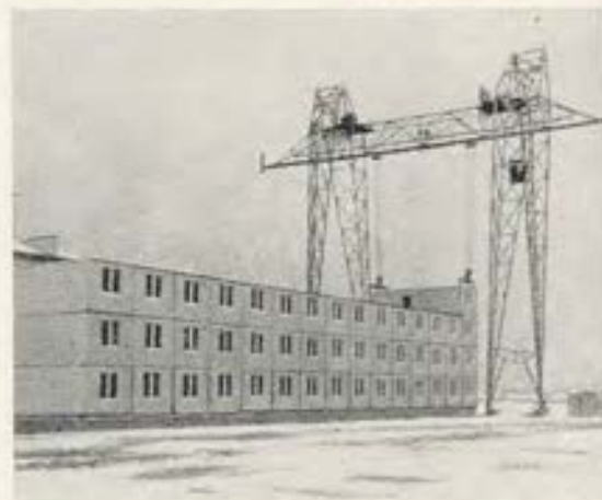
Montaje de piezas prefabricadas de gran tamaño en la Unión Soviética
