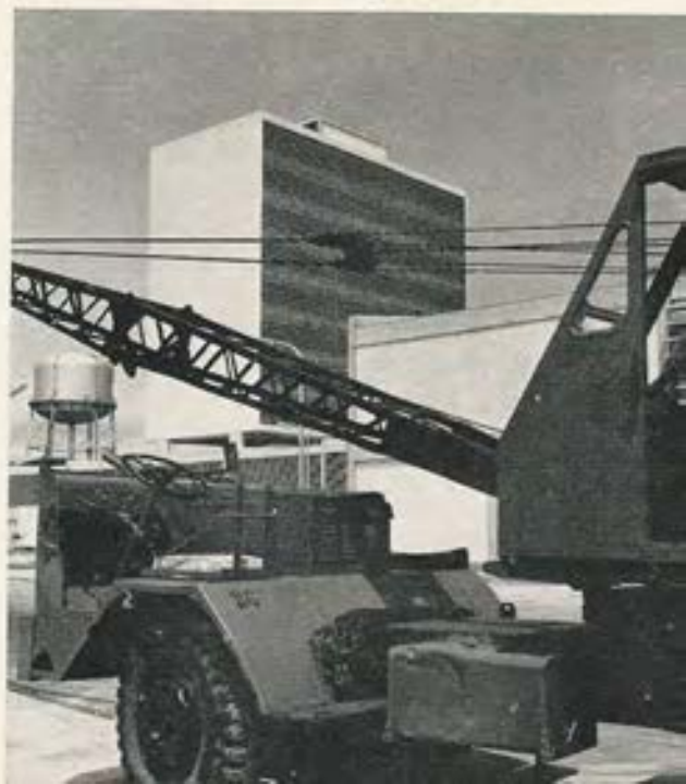
Detalle de la Aduana de Puerto Cabello Arq. Julián Ferris
