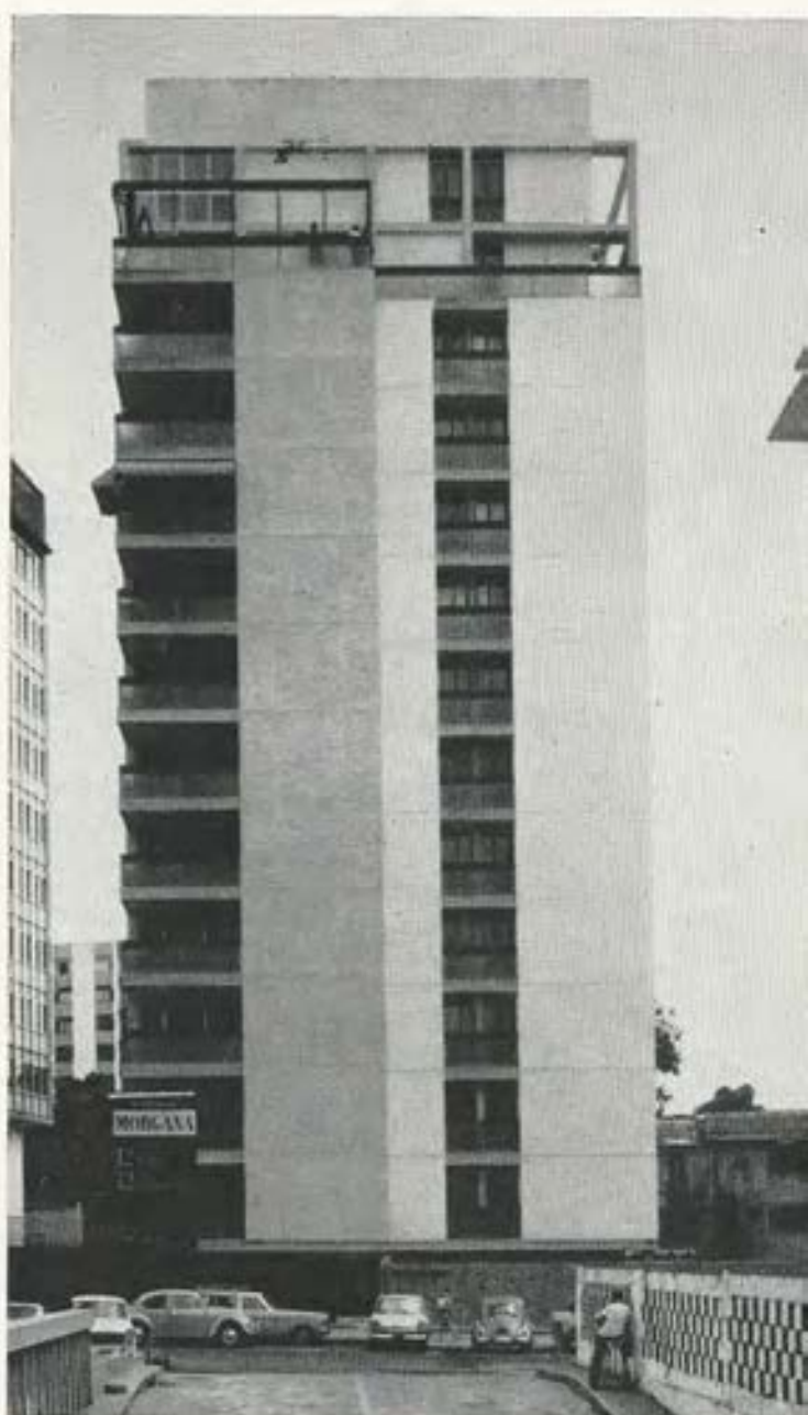
Residencias Morgana, Caracas. Arq. Carlos Guinand Baldó.
