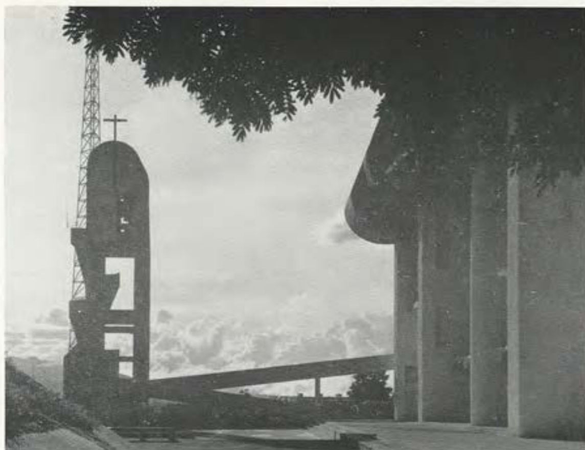
Capilla del Colegio La Salle. Arq. Carlos Guinand B.
