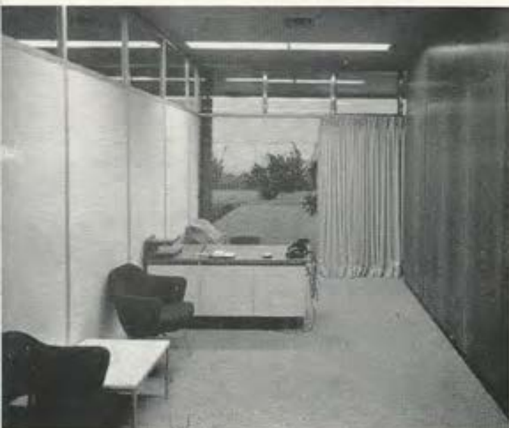
Edificio Oficinas Cauchos General (detalle interior). Arq. Guinand Baldó.
