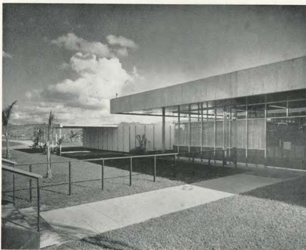
Edificio Oficinas Cauchos General. Arquitecto Carlos Guinand.
