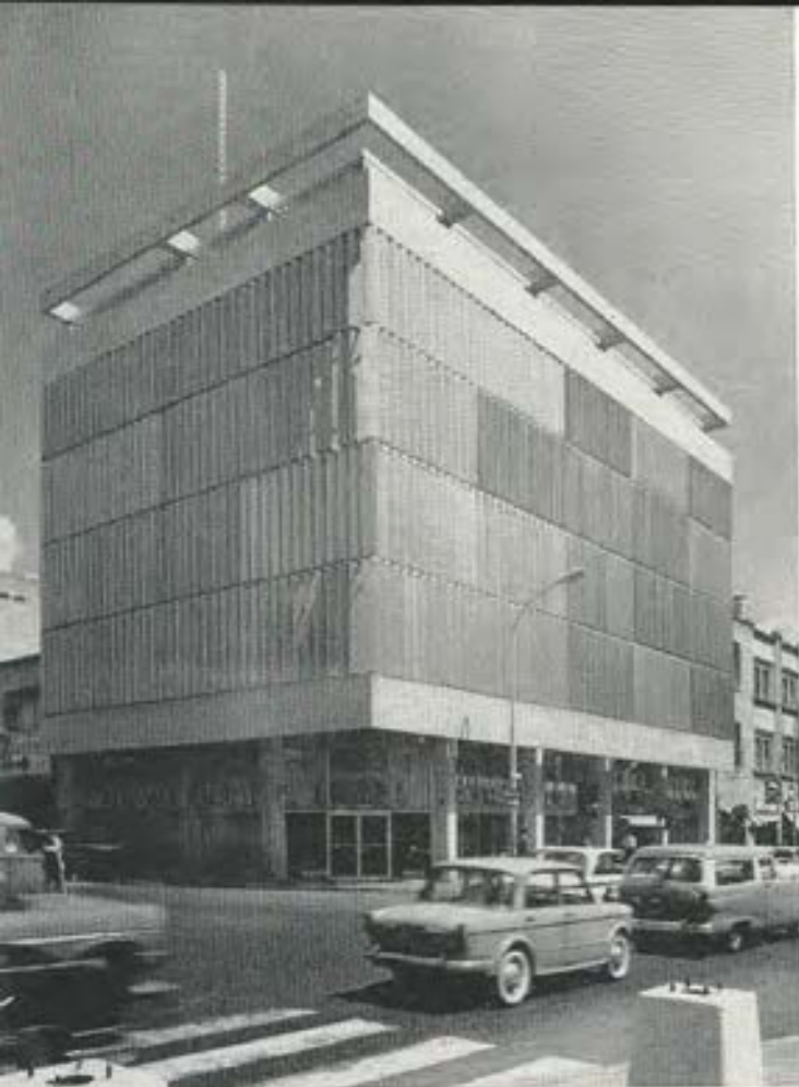
Edificio de Oficinas El Chorro, Caracas. Arq. Guinand Baldó.
