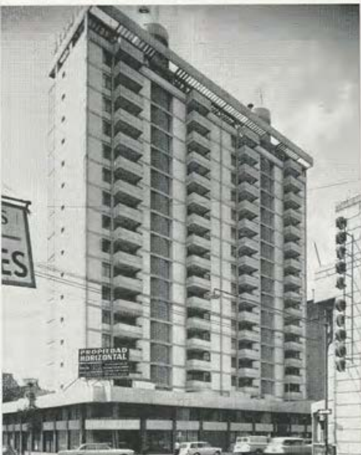
Edificio de viviendas Morelos, Caracas. Arq. Guinand Baldó.
