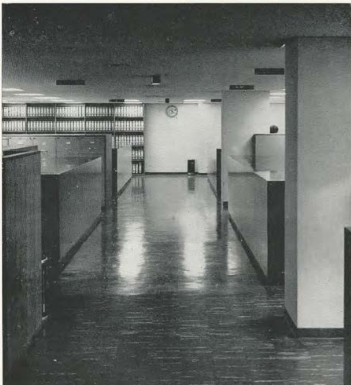
Edificio Seguros Caracas (interior). Arq. Guinand B.
