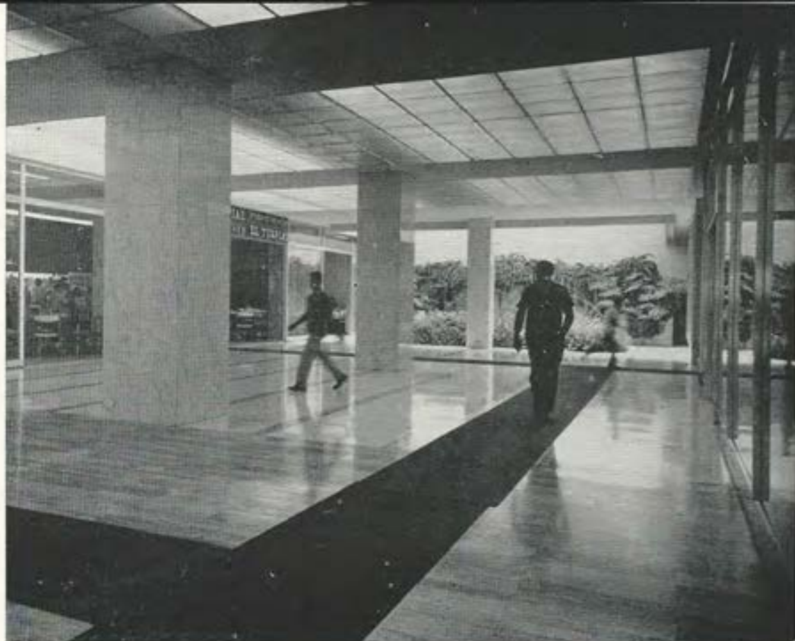
Edificio Seguros Caracas (interior). Arq. Guinand B.
