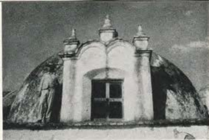
La ventana, ideada y ornamentada ingeniosamente por el artesano de la Colonia, tenía como función principal iluminar la típica cúpula teocuyana.
