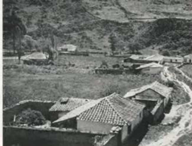
San Rafael de Mucuchies. Características casas andinas con el patio cercado.
