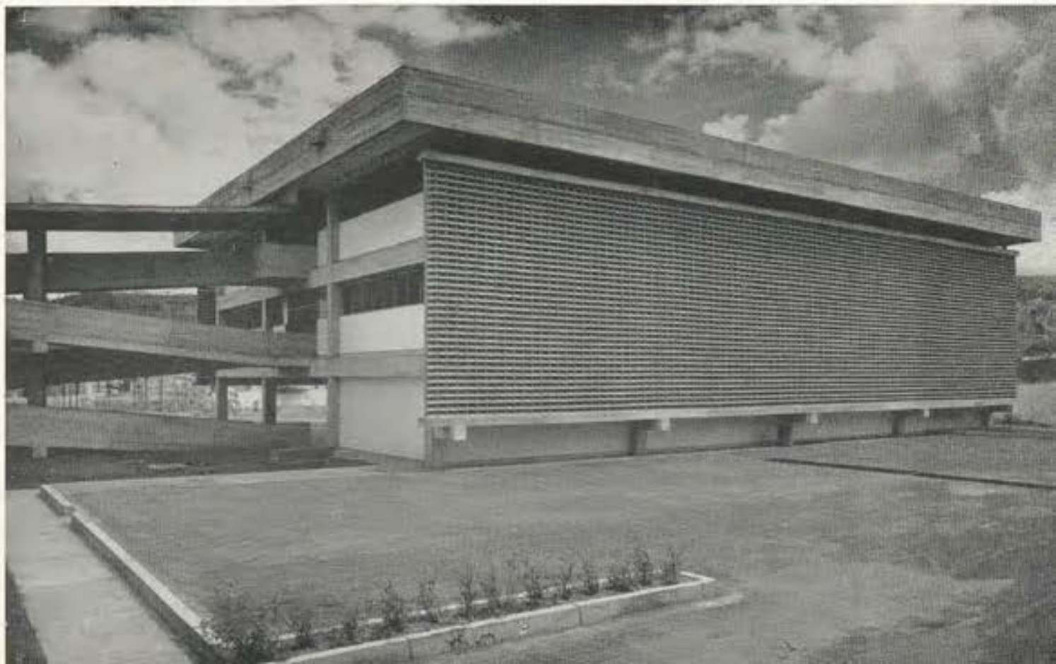
Liceo en Los Rosales; Laboratorios (Protección solar de la fachada oeste). Arq. Pedro Lluberes.
