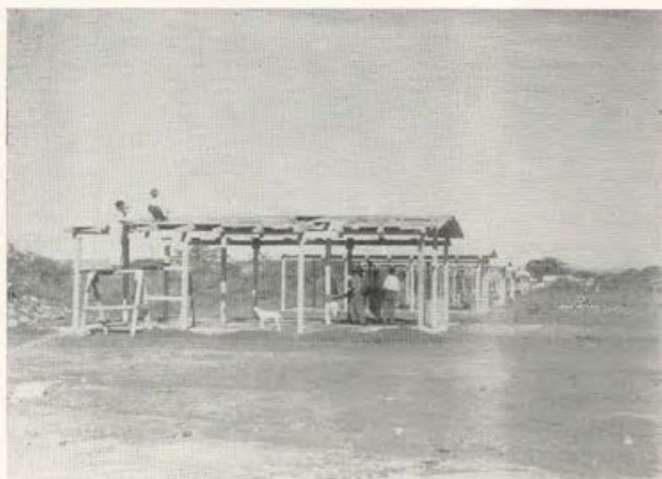
Conjunto de viviendas económicas a base de elementos prefabricados. (Vivienda venezolana). Arquitecto Pedro Ulleres.
