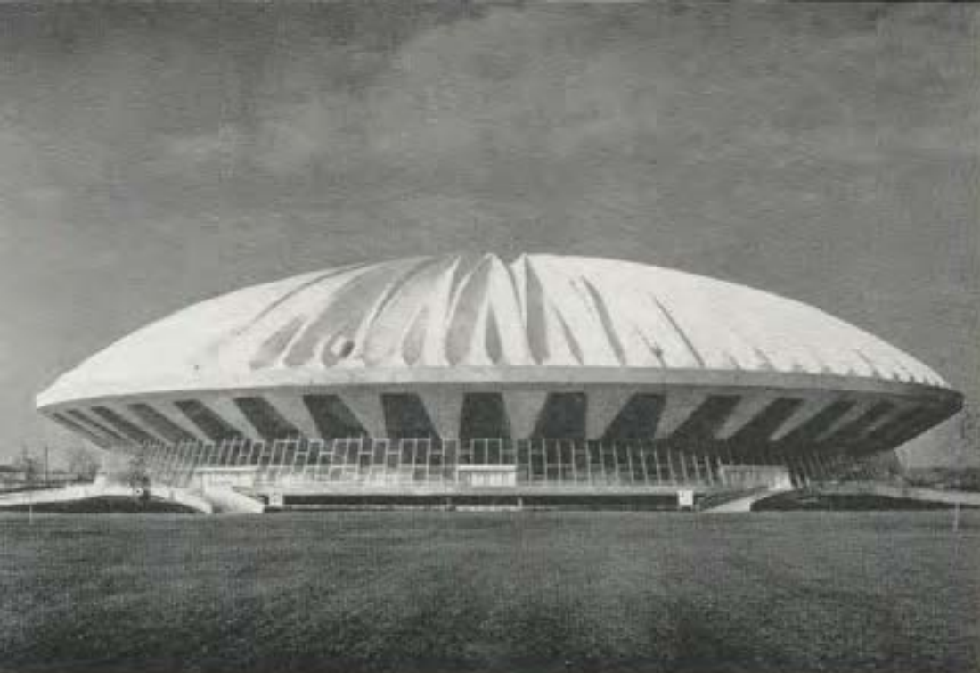
Edificio para conciertos y deportes. La Sala de Asambleas de la Universidad de Illinois con pliegues radiados es la mayor del mundo sostenido sólo por los bordes.
