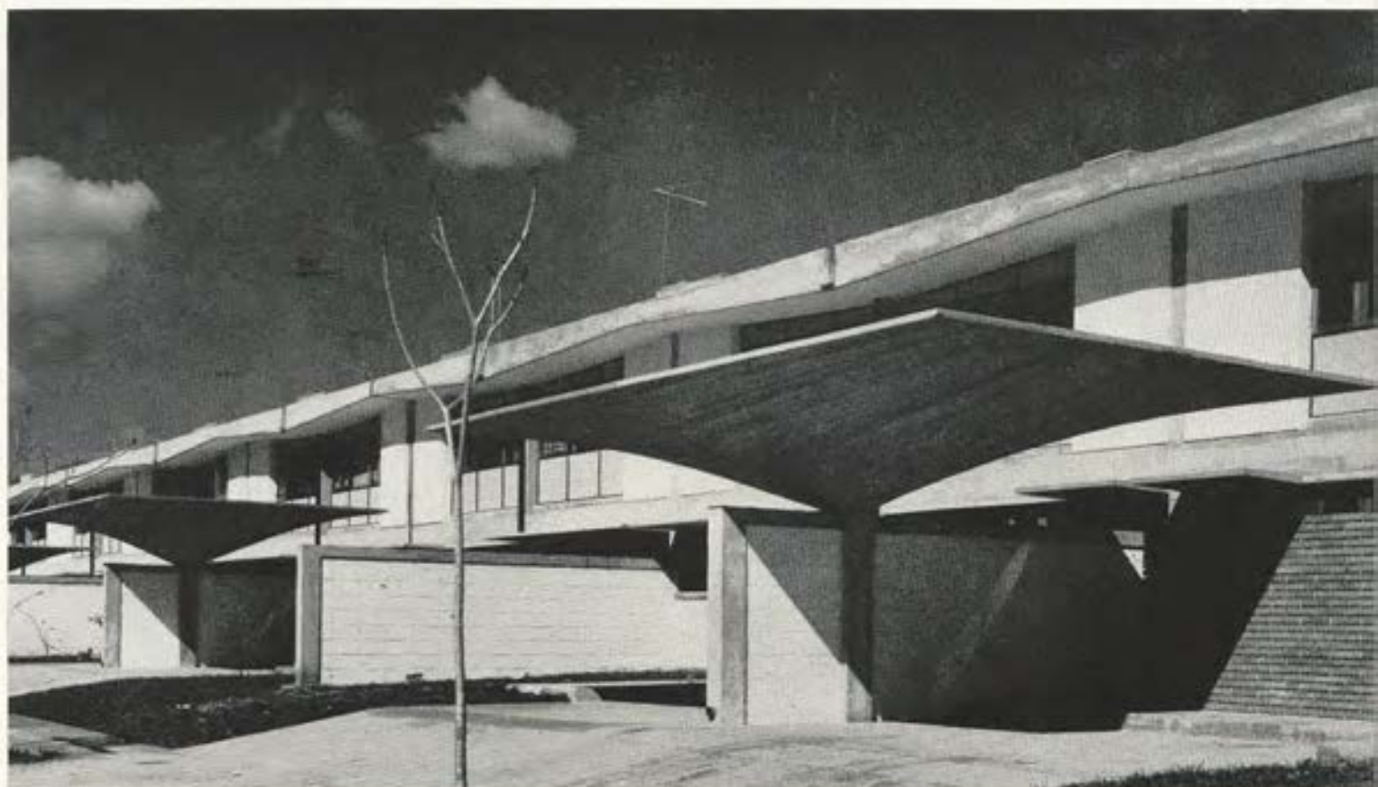
Conjunto de sesenta y ocho casas en Montalbón, La Vega, Caracas. Arq. Tomás J. Sanabria.
