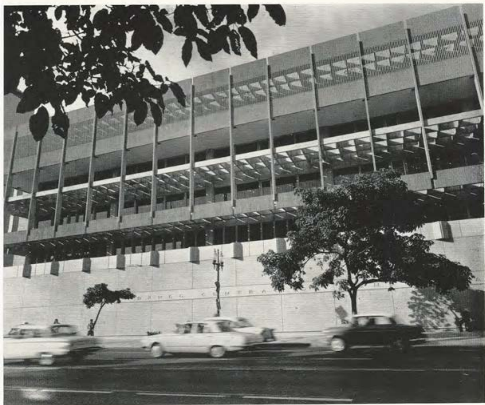
Fachada sur del Edificio del Banco Central de Venezuela, sobre la Avenida Urdaneta, Arq. Tomás J. Sanabria.
