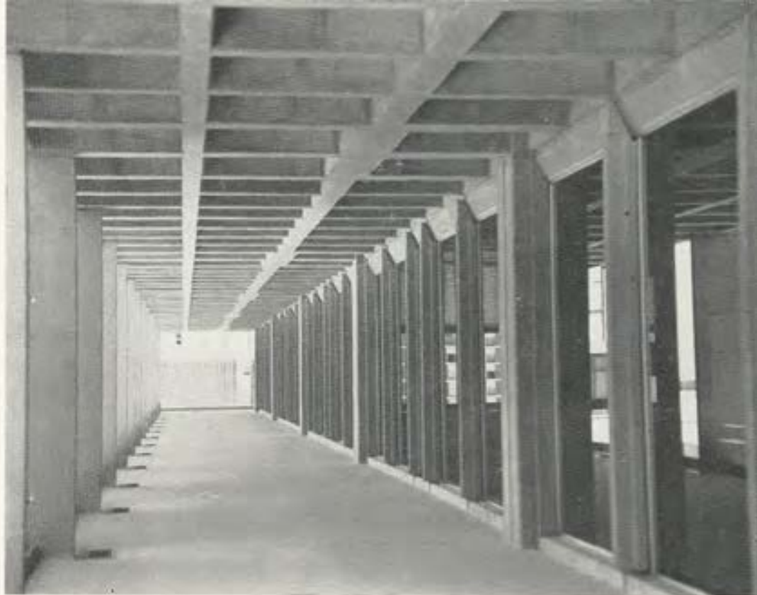
Detalle de zona de pérgola perimetral para control solar. (Nótese elementos prefabricados).
