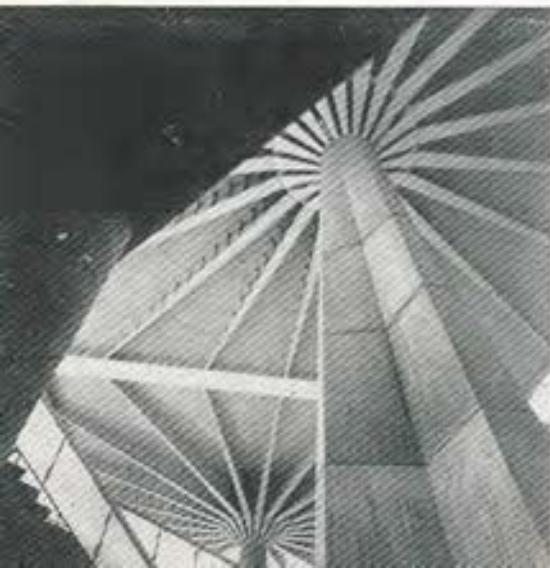
Palacio del Trabajo, Turín, 1960-61. Detalles de columnas. Nervi.
