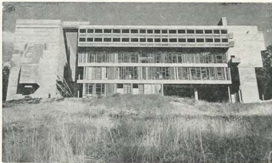
Fachada oeste del Convento La Tourette. Le Corbusier.
