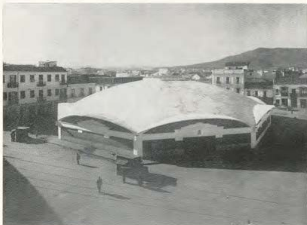
Mercado de Algeciras, España. 1934-35. Ing. Torroja, Arq. Sánchez Areas.
