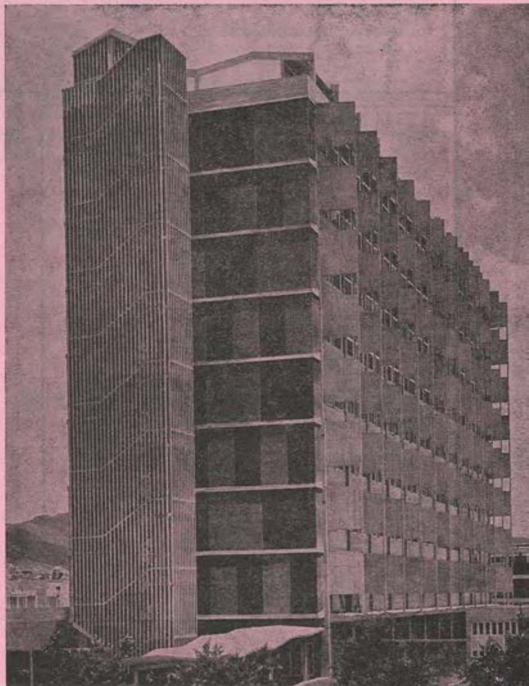
Edificio de la Facultad de Arquitectura. Ciudad Universitaria. Arg. Villanueva.
