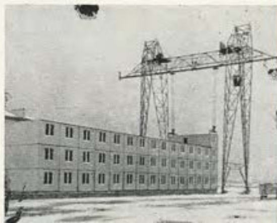
Montaje de pieza prefabricada de gran tamaño. Rusia.
