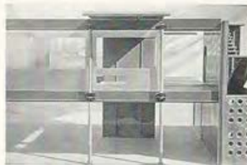
Maqueta de un inmueble H.M., de cinco pisos, realizable con solamente tres tipos de piezas independientes. Arq. Prouvé.
