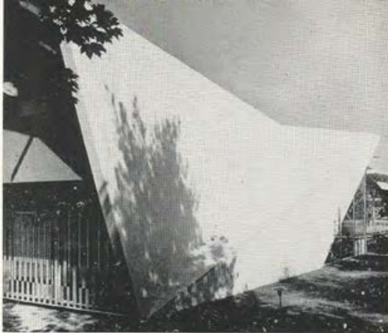
Pabellón de Venezuela en la INTERBAU, Berlín, Alemania, 1957. (Fachada lateral). Arq. Guido Bermúdez.
